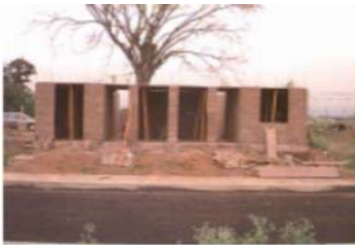
Casa en construcción
