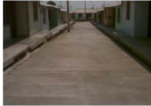
PAVIMENTO EN EJECUCIÓN
